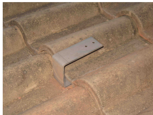
Crochet de toiture posé
