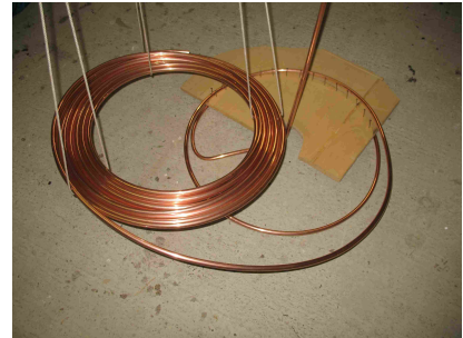
Réalisation d'un serpentin à l'aide d'un gabarit
