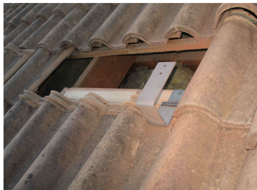
Pose d'un crochet de toiture
