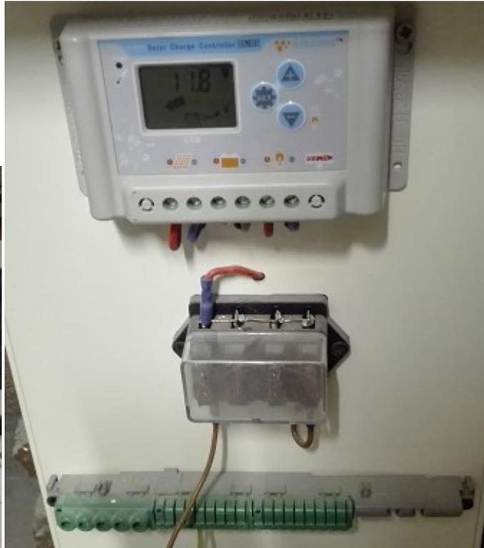
Pour la gestion de la commutation, j'ai fait le choix d'un relais temporisé programmable 12V qui lors de la coupure va fermer un circuit 220V qui va alimenter un transformateur 220/12v au format DIN. Ce temps d'alimentation secouru secteur est défini par le relais. (Actuellement placé sur 3h)
