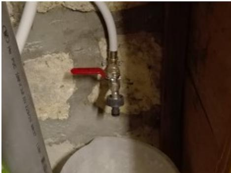
Au niveau des toilettes, il est possible grâce à un doublage des flotteurs, de passer de l'eau de la cuve à l'eau potables en cas de problème. (Estimation de besoin annuel : 30m<sup>3</sup>)(Surface de collecte ~24m<sup>2</sup>)
