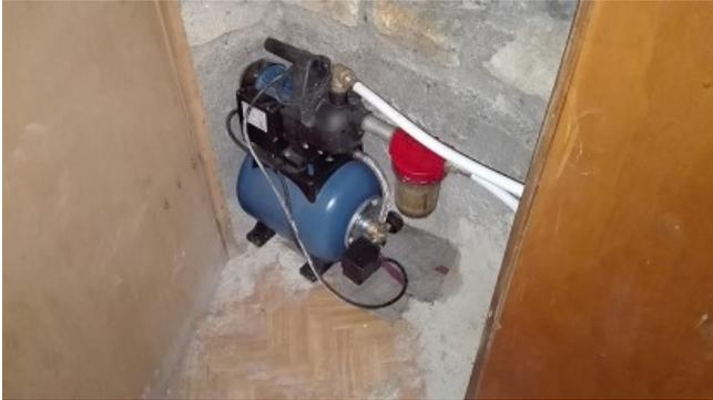
Le circuit alimente aussi 2 robinets spécifiques dans la cave pour mettre à disposition cette eau non potable pour les travaux, le nettoyeur haute pression ou le nettoyage d'outils.
